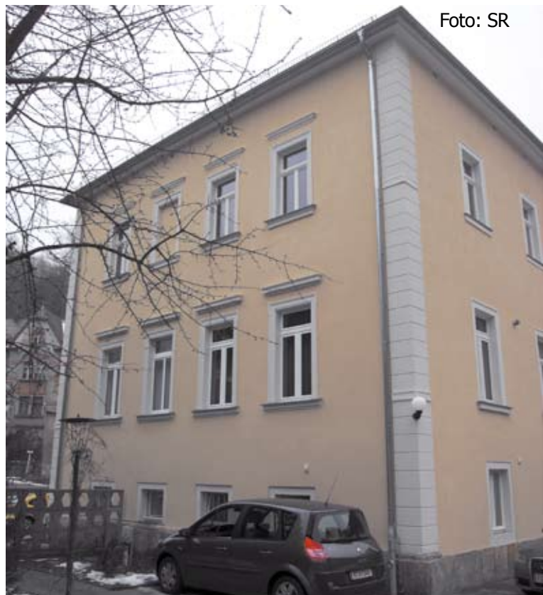
Das Haus der Familie von Seydewitz in Tharandt ist ein Schmuckstück. Dank der BHS-Mauerentfeuchtung gehören feuchtes Mauerwerk durch aufsteigende Nässe der Vergangenheit an.
