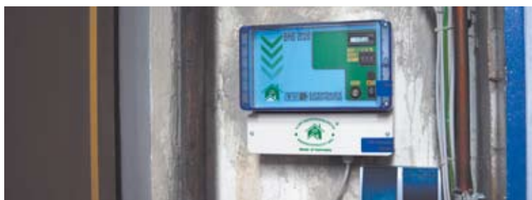
Das Wohnhaus in Wriezen erlebte so manche erfolglose Sanierungsmaßnahme. Erst nachdem im Keller ein zertifiziertes Mauerentfeuchtungsgerät der Firma BHS SCHREITER & KROLL GmbH eingebaut wurde, sind die Mauern spür- und messbar trockener geworden.
