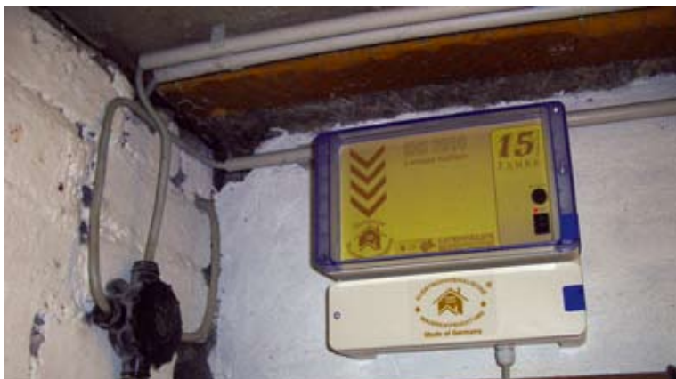
Dank dem BHS-Mauerentfeuchtungsgerät bleiben die Wände auch in Zukunft trocken, so dass die Nutzung des Kellers als Versammlungsraum gewährleistet ist.
