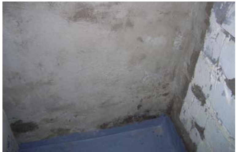
Durch eine Fehlsanierung in früheren Jahren staute sich die Feuchtigkeit im Fußboden des Gebäudes, was auch die Wände in Mitleidenschaft zog.
