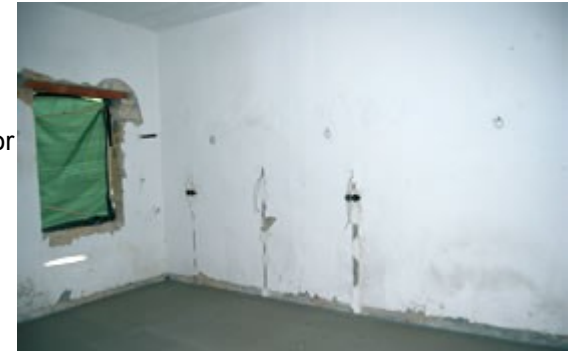
Die Bauarbeiten gehen voran. Fußbodenheizung, Elektrik und Decke sind schon fertig.
