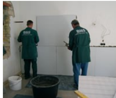
Auch die Firma Schreiter & Kroll aus Waldheim möchte helfen! Mit der Anbringung von BHS-Klimaplatzen wird die Wärmedämmung und das Raumklima des Gebäudes entscheidend verbessert.
